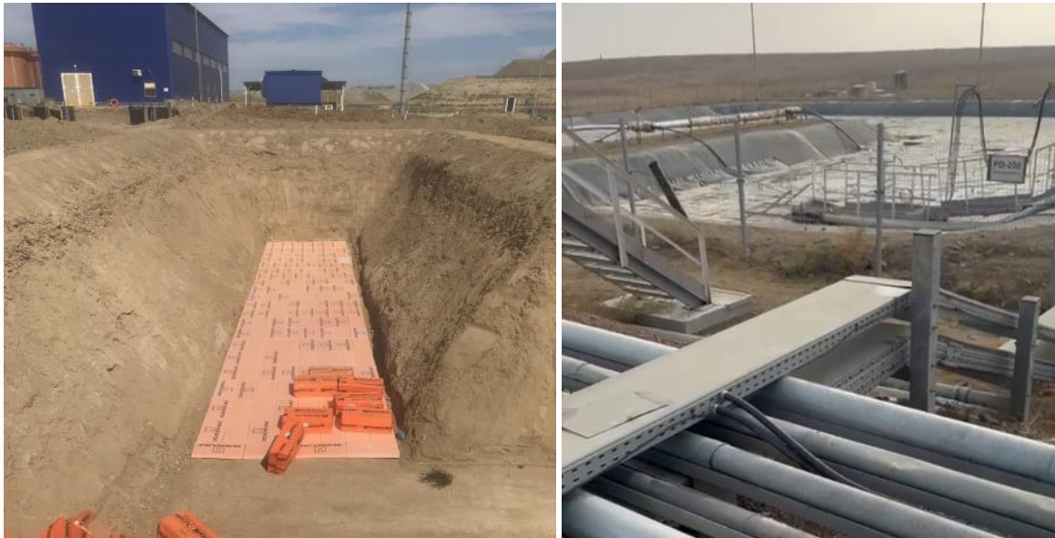
Рис.12 Инокуляция. Строительство пруда инокулята с использованием теплоизоляционного материала Пеноплекс и геомембраны.
