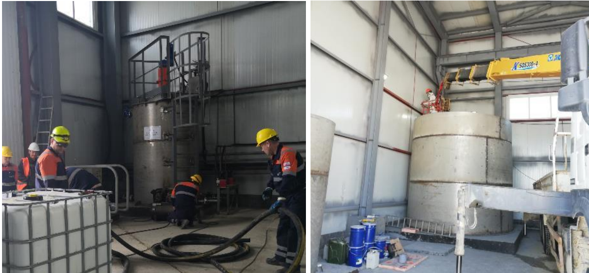
Рис.11 Инокуляция. Расширение насосной станции рафината для размещения питательного (ТК-100) и семенного (ТК-300) баков с насосами, а также склада хранения питательных веществ.
