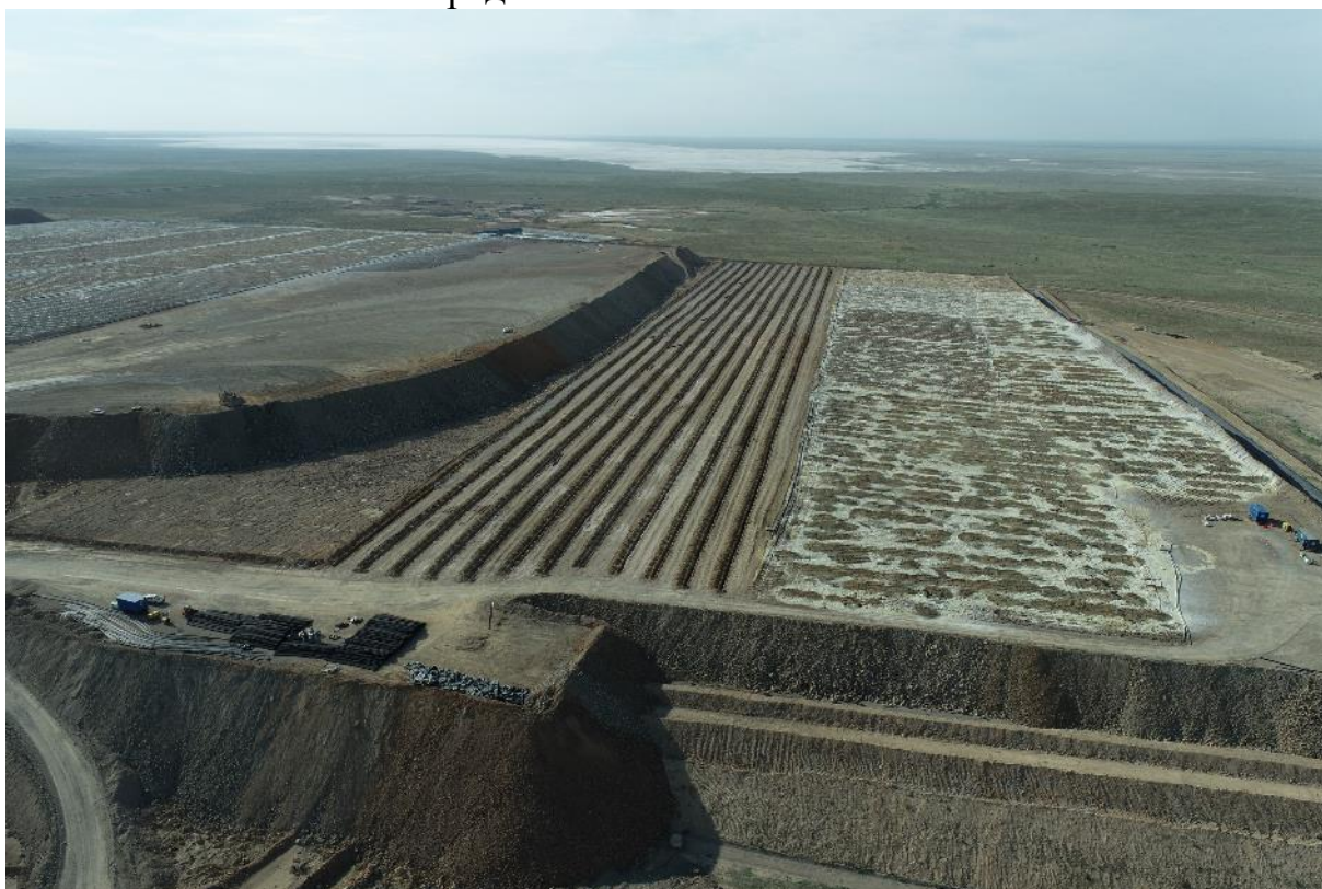
Рис.8 ПКВ-2. Укладка стрингерных труб системы принудительной аэрации
