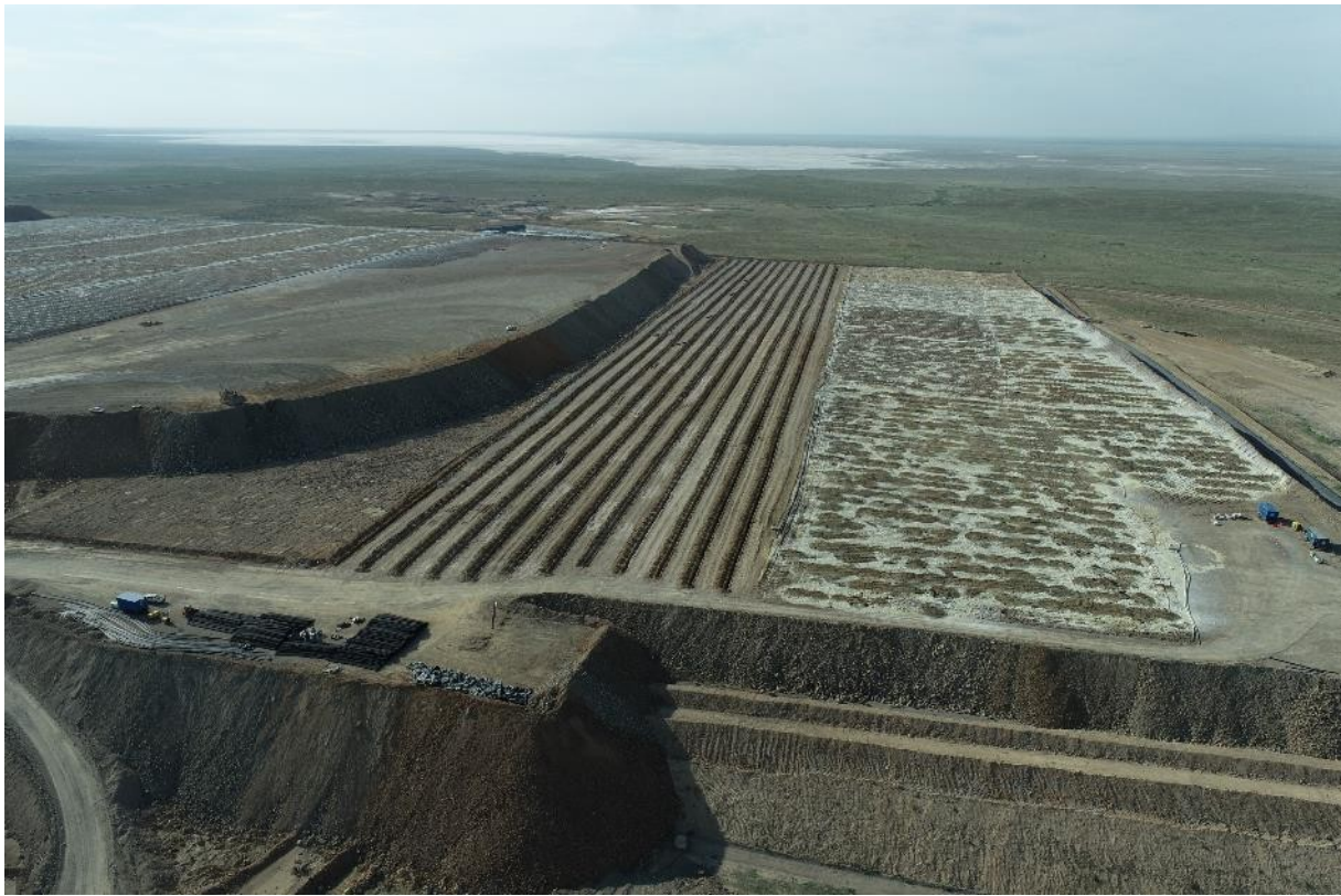
Рис.8 ПКВ-2. Укладка стрингерных труб системы принудительной аэрации
