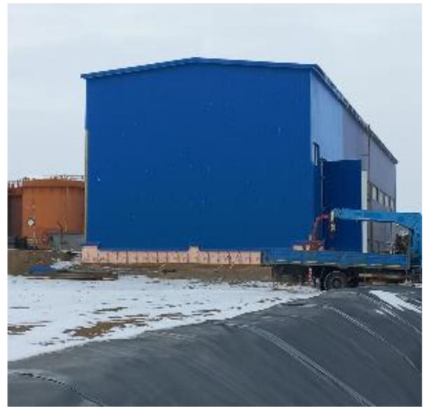
Рис.10 Инокуляция. Расширение насосной станции рафината для размещения питательного и семенного баков с насосами, а также склада хранения питательных веществ.
